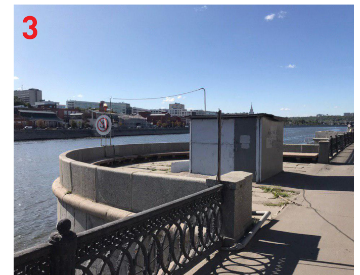
Большое количество инженерных коммуникаций на поверхности земли
